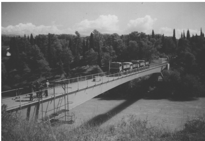
Slike 9 i 10. Položaj probnog opterećenja u toku ispitivanja konstrukcije
